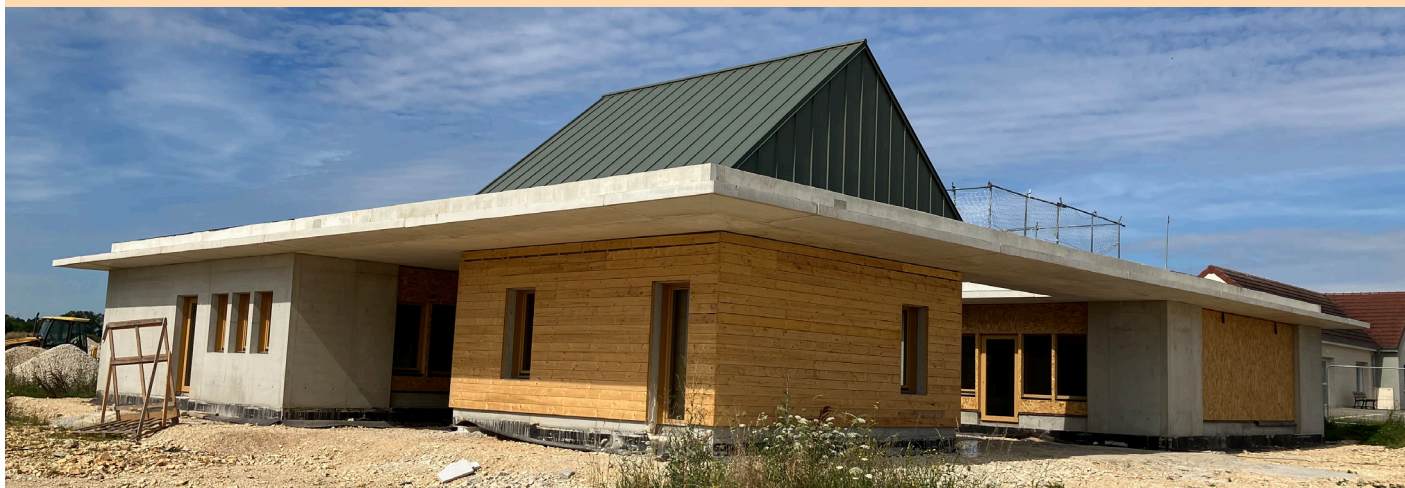
Construction en cours de la Maison de santé pluriprofessionnelle
